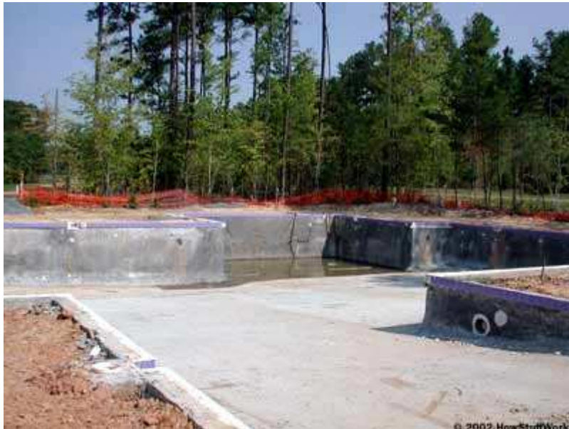
建造中的公寓楼泳池：它看上去像是地上挖了一个大坑，但实际上却要复杂得多。
