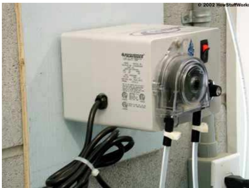
连接到水泵和过滤系统的自动进氯器
